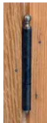
Fiches à lames forgées style XVIII ème pointées aux clous
